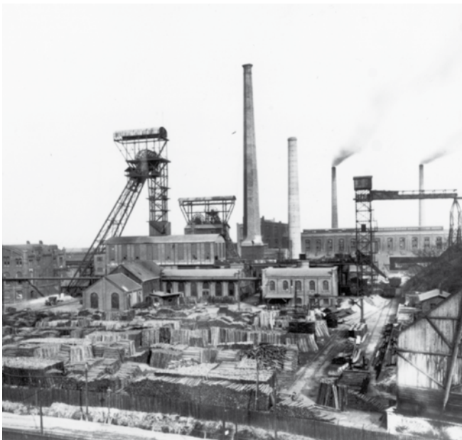
Bild 4: Zeche Oberhausen – Malakofftürme durch Stahlfördergerüste ersetzt in 1914
