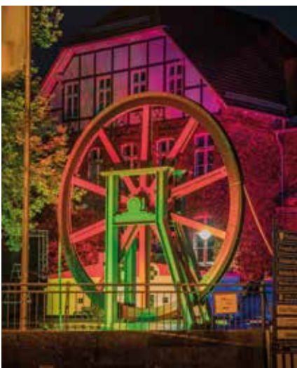
Bild 8: Beleuchtetes Kalibergbau-Museum in Heringen
