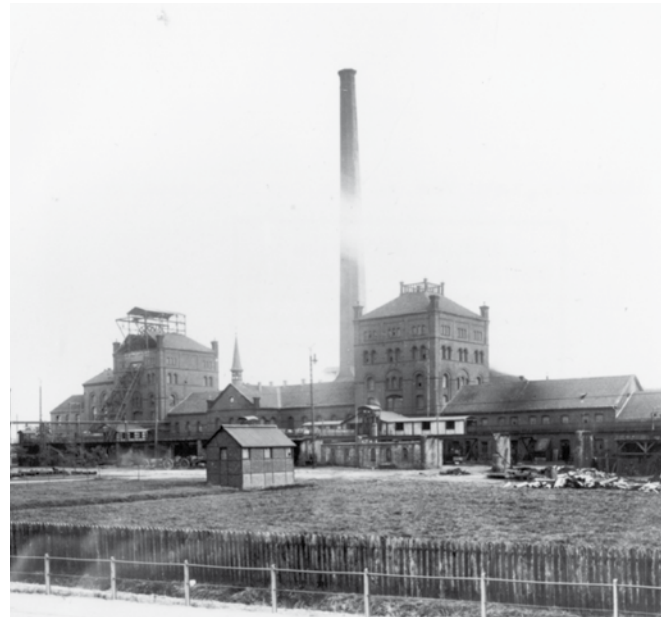
Bild 3: Zeche Oberhausen – Stahlfördergerüst ist in Malakoffturm eingebaut – in 1904
