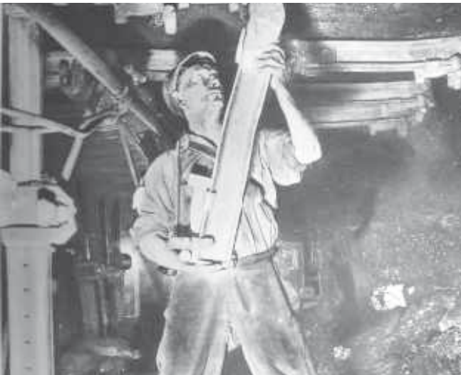
Bild 13: Strebausbau mit Stahlstempeln
