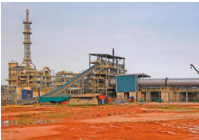
Bild 19: Neue Aufbereitungsfabrik für Seltene Erden in Malaysia
